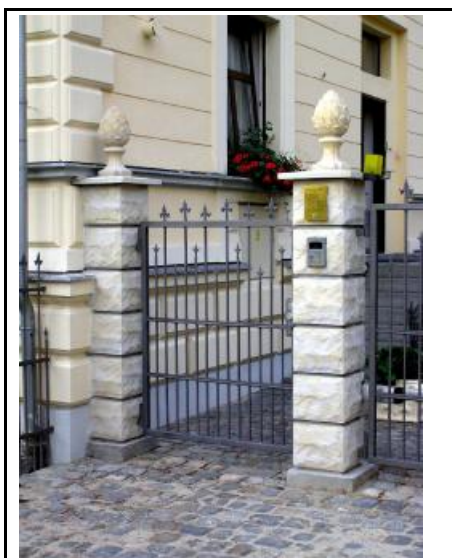
fotografie sloupku z bloků MAX . Na sloupku je šiška pinie (obj. číslo 20-104) (foto)
