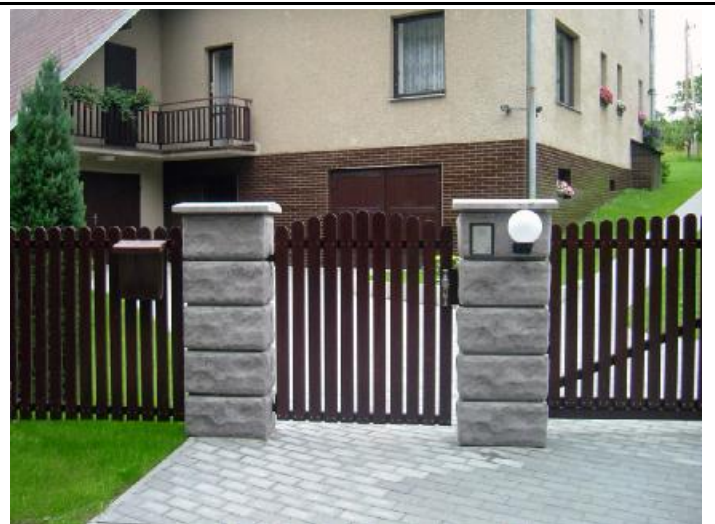
detail sloupku: jako sloupkové hlavice jsou použity hladké hlavice pro bloky DOMINANT (foto)
