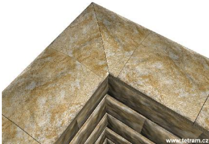
roh je tvořen dvěma hlavicemi seříznutými pod úhlem 45 stupňů (model)
